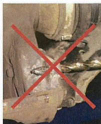
② 損傷しためねじを ドリルで加工
