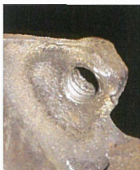
① ブレーキキャリパー 損傷
